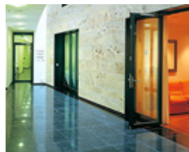
Drzwi i ścianki stalowe ppoż
