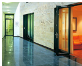
Drzwi i ścianki stalowe ppoż
